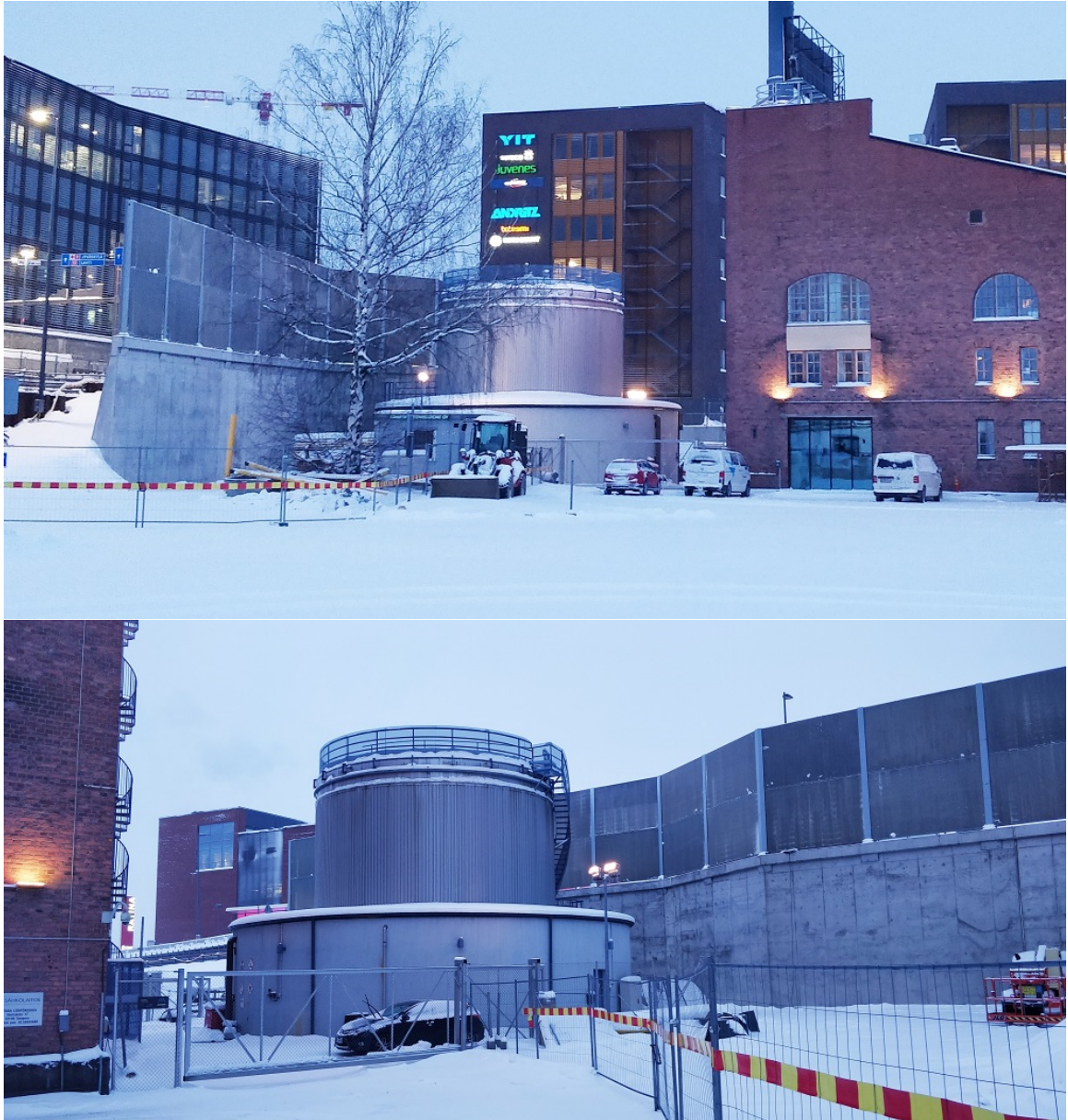
Kuva 4. Öljysäiliö ja sen pohjoispuolella oleva suojamuuri.
